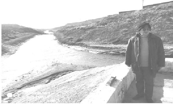
Рис. 1. Заиление входного участка канала и водоприёмника.
