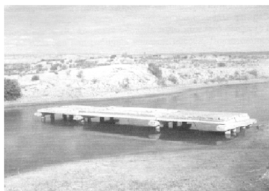
Рис. 4. Водоподводящие сооружения НС «Каратерен»: 1 - подводящий канал, 2 - аванкамера; 3 - всасывающие трубы; 4 - насосы.
