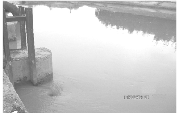
Рис. 1. Заиление входного участка канала и водоприёмника.
